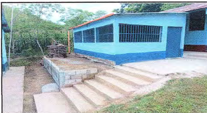
Foto 3: Pintado de paredes de la sustitución de cocina.
