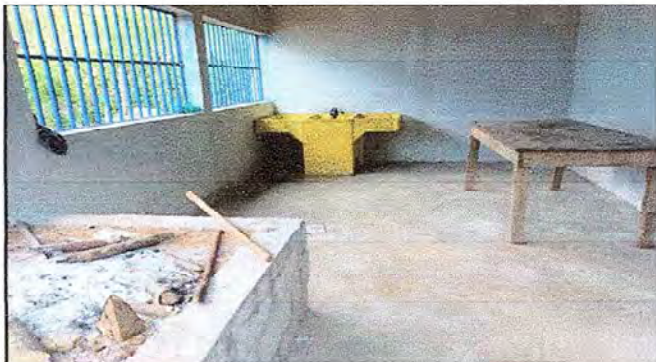
Foto 4: Acabados del interior de la cocina.
