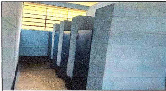
Foto 6: Pintado de puertas y Sanitarios instalados.
