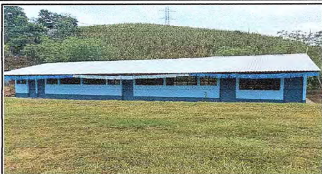
Foto1: Parte frontal del establecimiento educativo, estructura y enlaminado.
