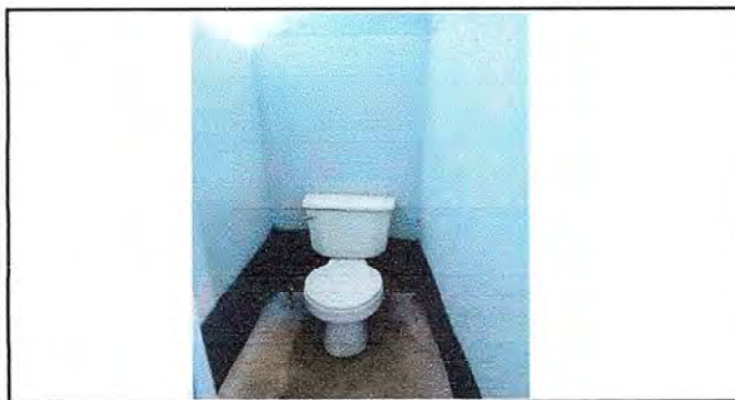
Foto 5: Sanitarios en perfectas condiciones.
